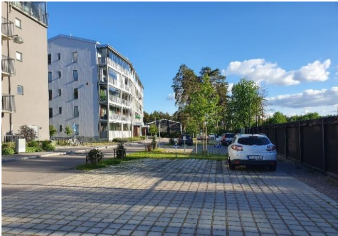
Figur 14) Parkeringsyta bestående av marksten med genomsläppliga fogar vid bostadsområde. (Foto Tyréns AB)
