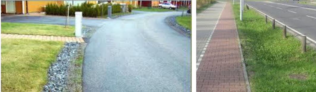
Figur 16) Till h: Makadamdike längs med gata inom bostadsområde. Till v: Gräsbeklätt infiltrationsstråk för avvattning av gata och gc-väg. Bildkälla: Stockholm vatten och avfall.
