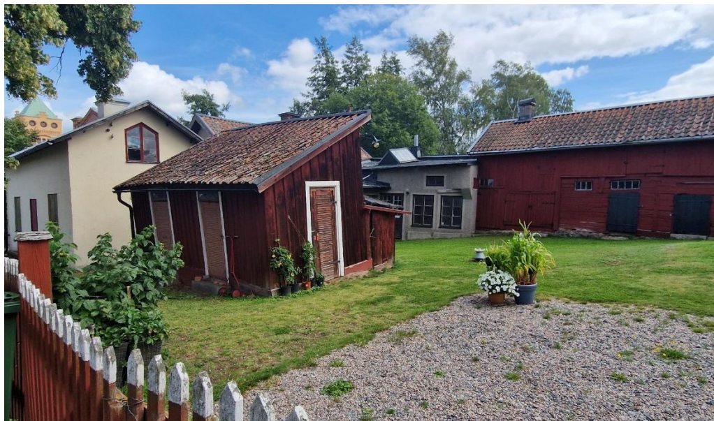
Vy mot sydöst från Karlbergsgatan mot Nyströmska gården och planområdet. Den mindre röda byggnaden närmast i bild användes som antråde. Den röda byggnaden som gränsar till planområdet användes som fähus. (Foto WSP)
