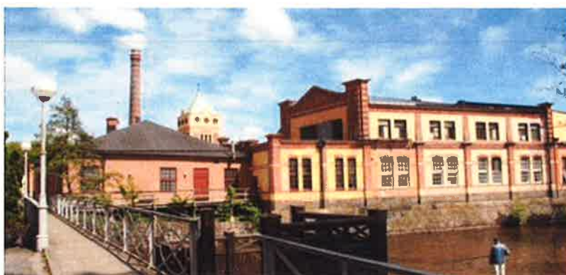
Delar av KMV-kvarteret renoveras och byggs om
