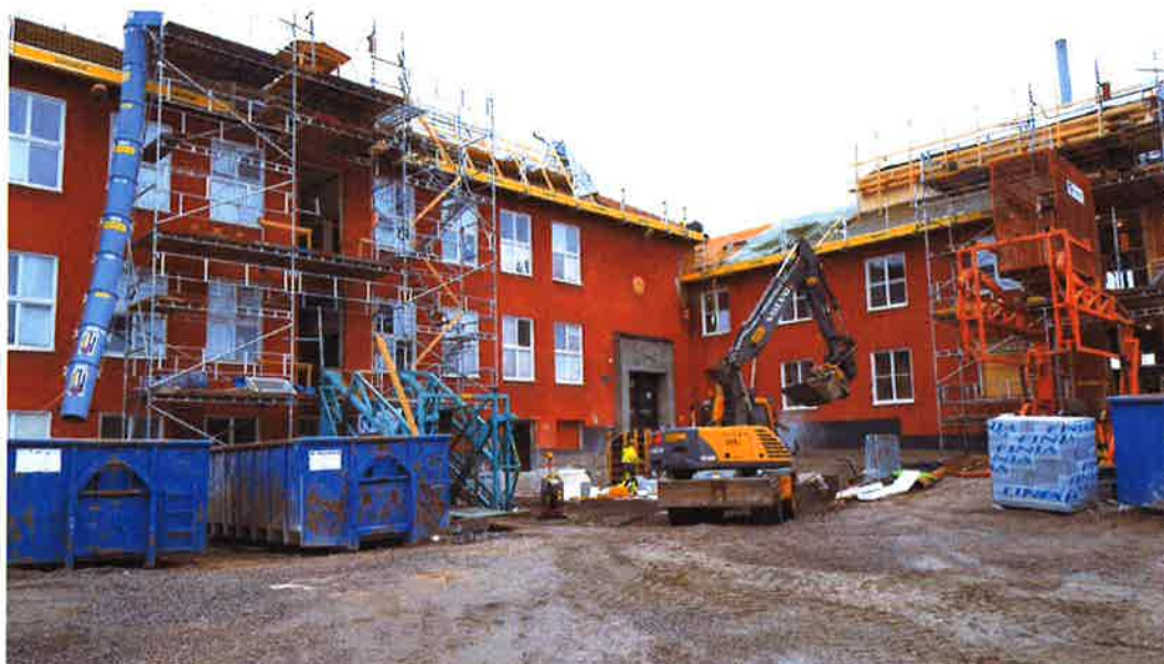
Renovering av S:t Olovsskolans annexbyggnad, maj 2016.
