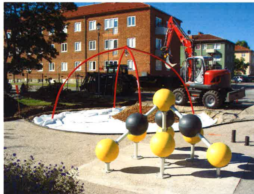
Anläggning av Scheeletorget's lekplats. Scheeletorget's lekplats är en tillgänglighetsanpassad lekplats där delar av markmaterialet består av gummiasfalt.
