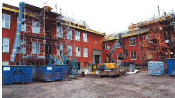
Renovering av S:t Olovsskolans annexbyggnad
