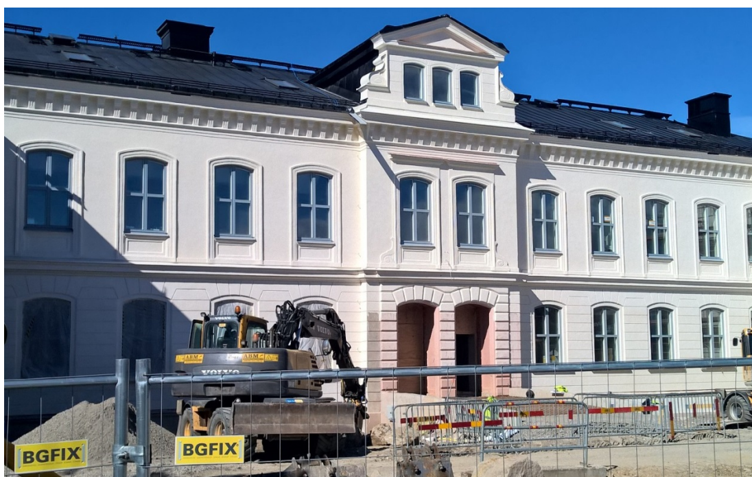
Renovering av S:t Olovsskolan, etapp 1, huvudbyggnaden, maj 2015
