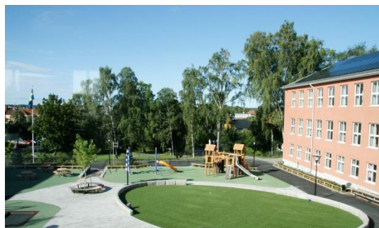
S:t Olovsskolans nyrenoverade annexbyggnad
