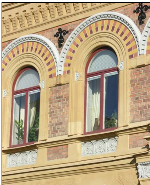
Del av fasaden på apotekshuset (Disa 2).
