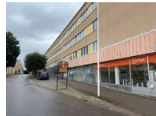
5. Storskalig byggnad med stark horisontalitet i puts och plåt, Stora gatan.
