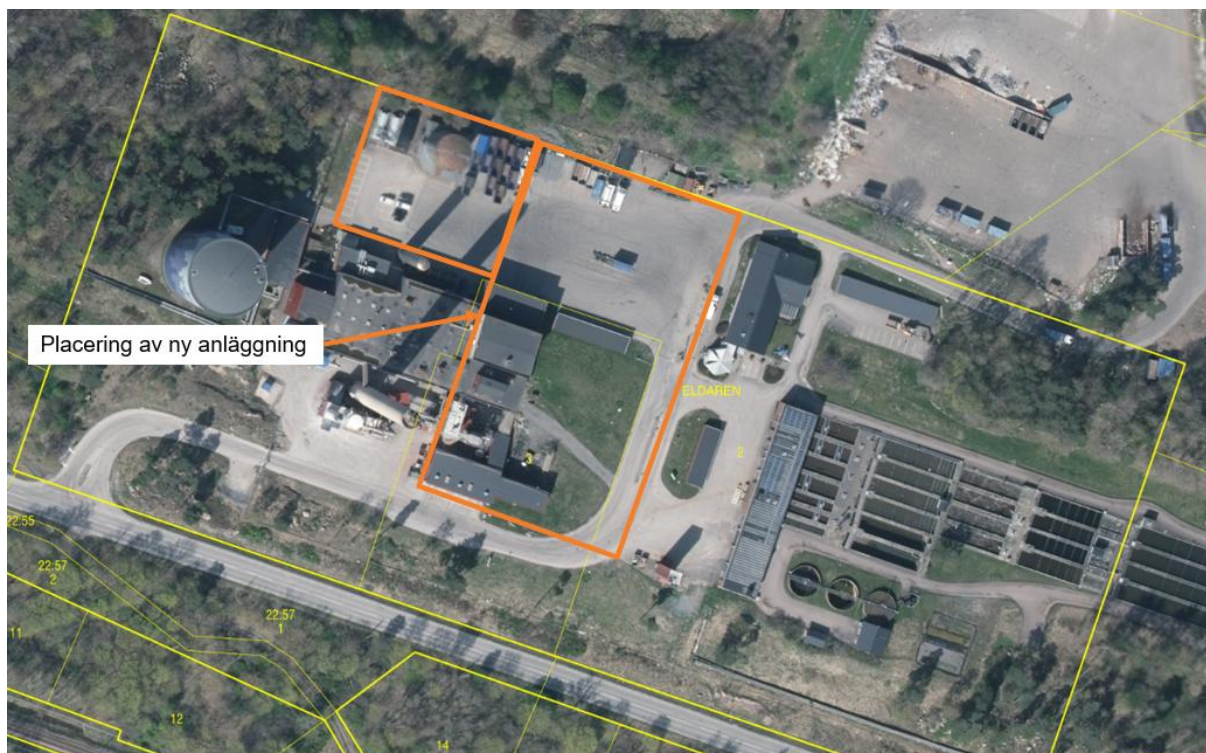
Figur 7. Flygfoto över Norsaverket med den tilltänkta placeringen av samförbränningsanläggningen.
