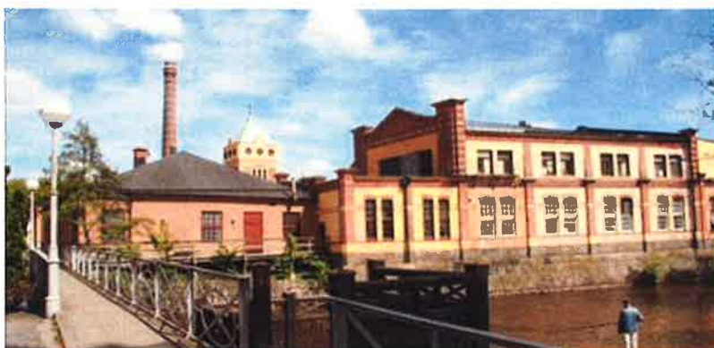
Delar av KMV-kvarteret renoveras och byggs om
