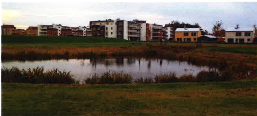
Figur 6. Öppen magasineringsdamm. Exempel från Falkenberg, Kristineslätt.
