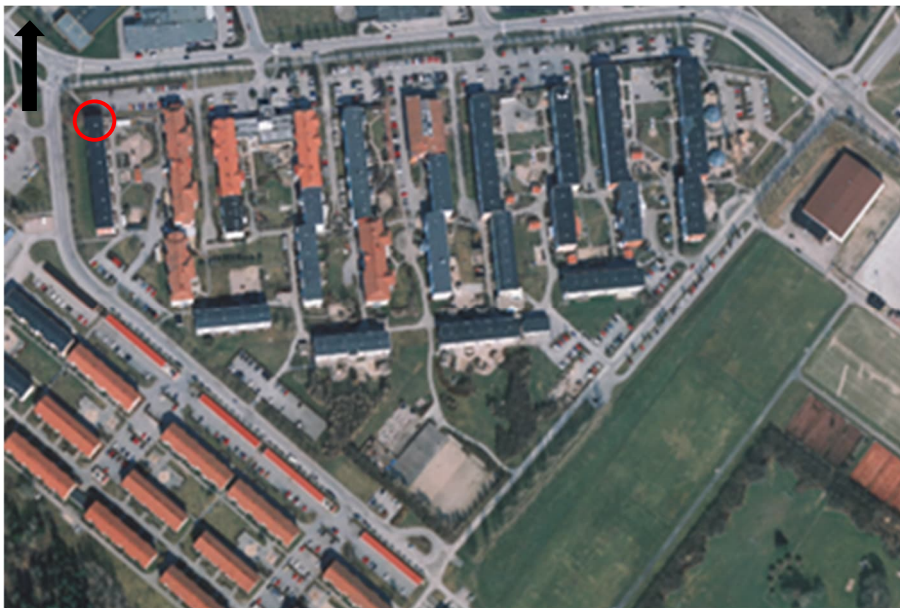
Figur 3. Flygfoto från år 2002 där man kan se lägenhetshuset i den västra delen av fastigheten som revs år 2005. Guldsmeden bedrev sin verksamhet i den norra delen av huset (röd markering)
