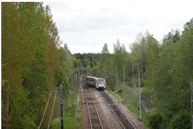
Figur 20 Infrastrukturåtgärder på Bergslagspendeln, exempelvis förlängning av mötesspår mellan Ramnäs och Brattheden, är viktiga för att öka såväl marknadsandel som pendling mellan norra länet och Västerås (foto: Till Klingenhäger)
