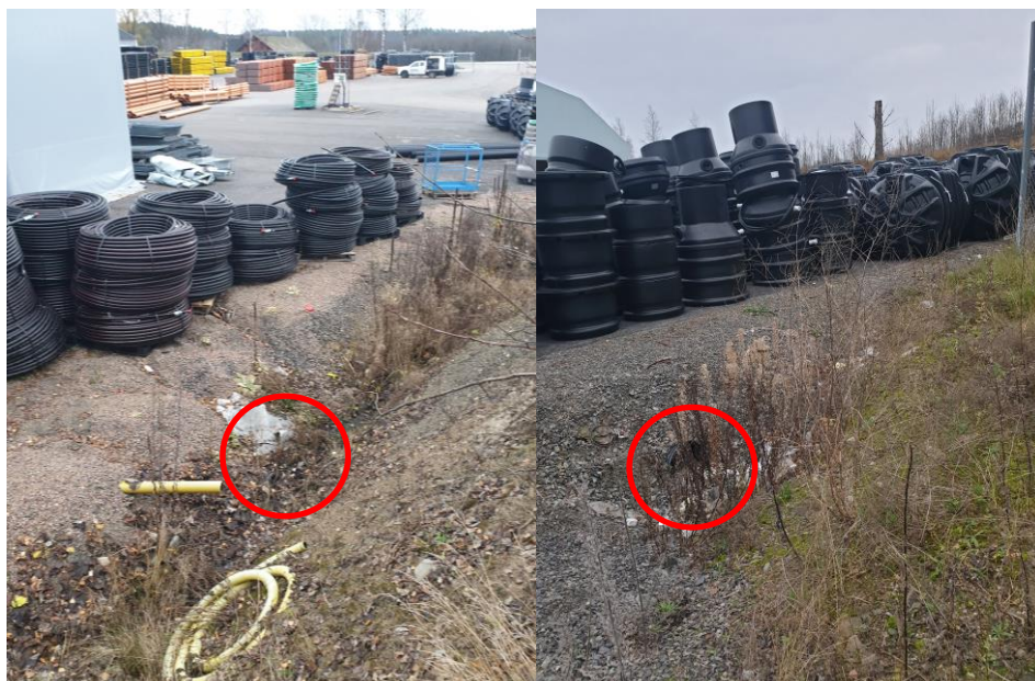
Figur 5. Till vänster visas befintlig ledning som kommer ut sydöst om stora tältet, och diket som leder dagvatten vidare. Till höger visas befintlig ledning som ligger nordost om stora tältet och troligen utgör ett inlopp till området.
